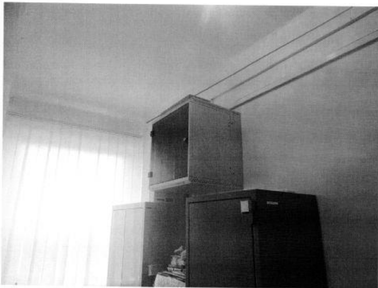
Obr. 5. Káblová trasa do elektrického rozvádzača.
