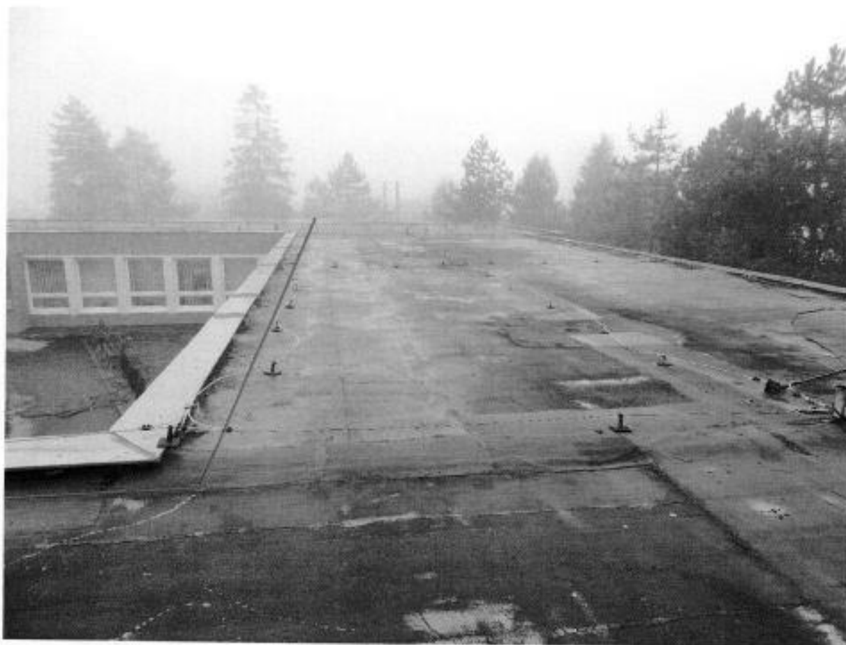
Obr. 3: Kábová trasa do elektrického rozvádzača.
